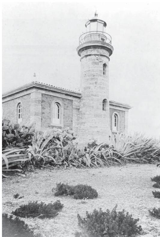
☉ El faro entró en funcionamiento el 15 de marzo de 1864, con un alcance de 12 millas. La primera torre era troncocónica. En 1882 se sustituyó el sistema de lámparas de mecha para aceite de oliva por una mecha que quemaba parafina. Electrificado en 1944, era guía para los barcos marbelleros y los que llegaban a La Rada. (Foto: Laurent, 1870. Probablemente la primera foto que exista de Marbella).
