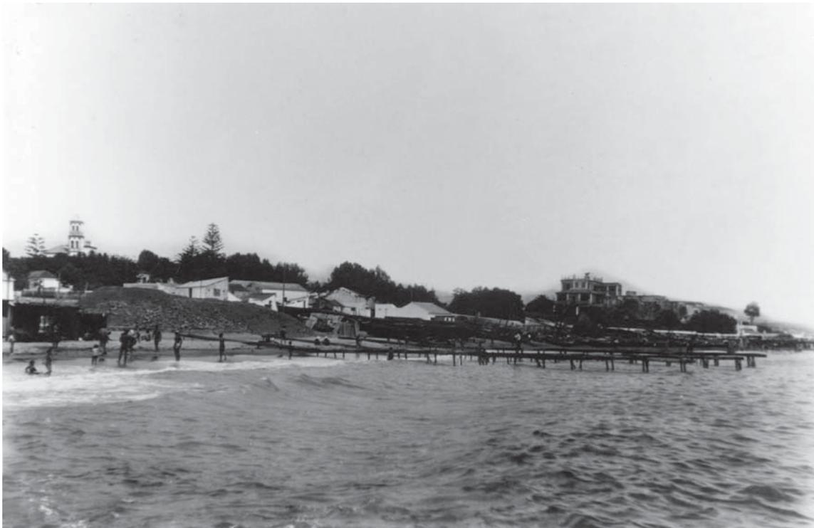
⊗ Embarcaderos de hierro y maderas de la empresa Ferarco. El mineral se depositaba en la orilla y se cargaba a hombros hasta las barcazas (Ediciones Juan Belón. Foto: Cortés).
