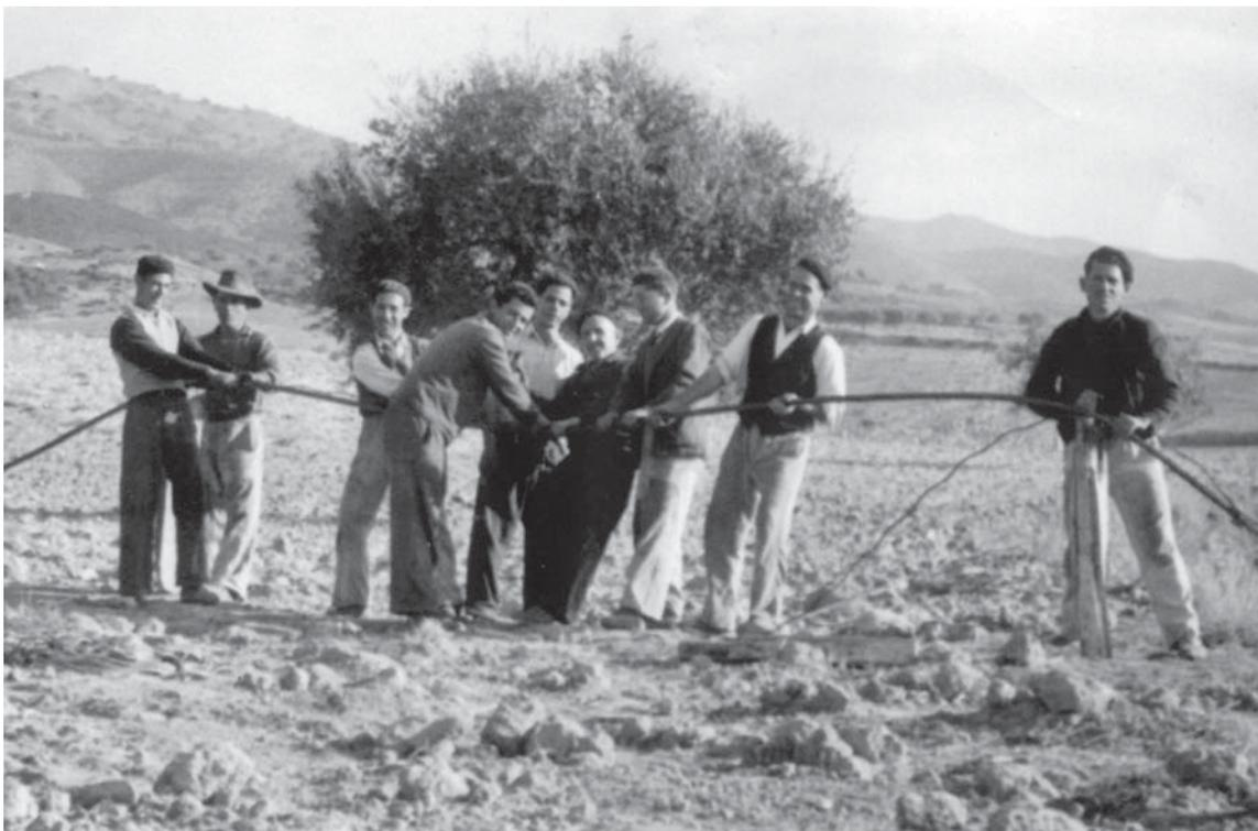
⊗ Operarios instalando el cable sobre el que colgaban las vagonetas que transportaban el mineral hasta los barcos. Tenía una capacidad de transporte de 200 toneladas por hora. Años 50.
